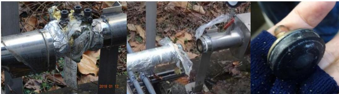
図15 冷却塔への水配管。(左・中央) 作業を行っている途中。(右) 摩耗した弁。
