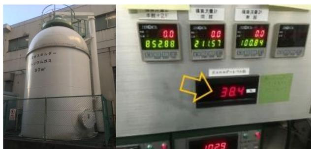
図 18 (左) 回収ガスホルダー。(右) レベル計の表示。
