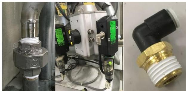
図 16 (左) 計装空気が漏れたユニオン継手。(中央) ガスが漏れた電磁バルブ。黒いチューブとエルボ継手の隙間から漏れた。(右) 交換部品。
