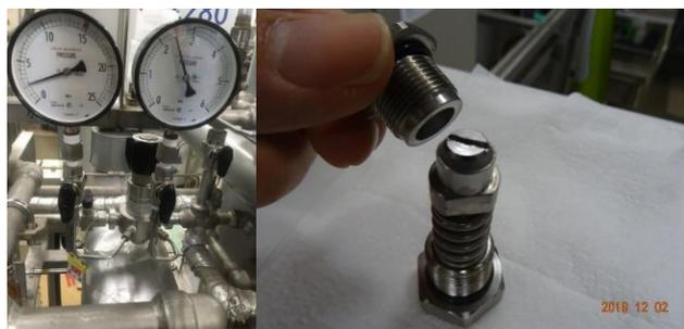
図7 (左) 圧力調整器。(右) 圧力調整器のパッキン交換作業。
