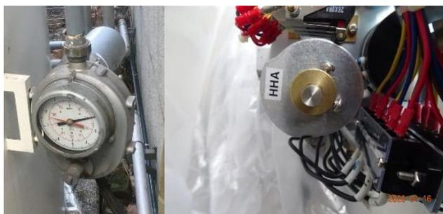
図 19 (左) レベル計。(右) レベル計内部。カムを回してスイッチを設定可能。
