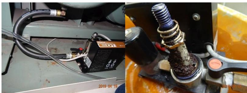
図 17 (左)新しいドレントラップ。(右) 古いドレントラップのストレーナ部分。
