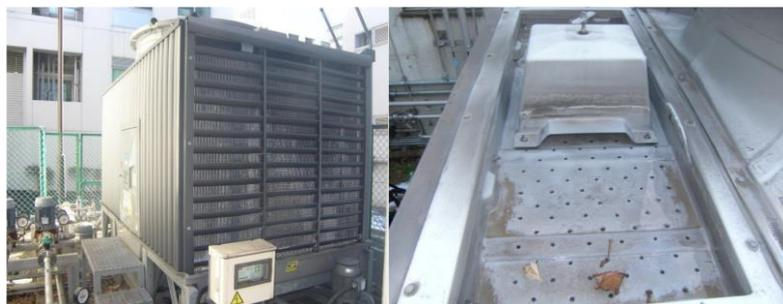
図1 (左) 冷却塔。(右) 散水板。
