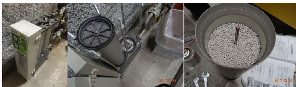
図3 (左) エアードライヤー。(中央) 交換作業中。(右) 吸着剤。
