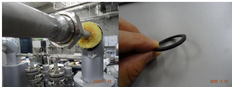
図 6 (左) 中圧ガスドライヤーガス漏れ箇所。(右) 間に入っていた弾力を失った O リング。
