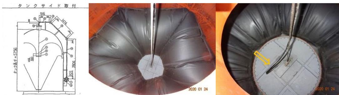
図 20 (左) ガスホルダー模式図。(中央・右) ガスホルダー内部を上部から撮影したもの。中央の方は、ガスがまだ少ない状態。右は、ガスが増えて、レベル計のワイヤーが弛んでいる。
