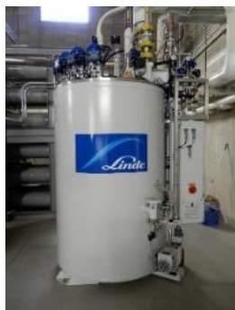
図5 ヘリウム液化機 ・L140 (Linde 社製) ・液化能力 100 L/h 以上 (純ガス使用時) ・内部精製方式 ・2020 年に更新
