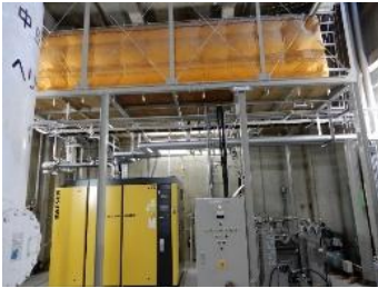
図 12 ガスバッグ(液化室) ・容量 31 m 3 ・2014 年新設
