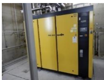
図6 ヘリウム液化用圧縮機 ・DSD205 (KAESER 社製) ・吐出流量 950 Nm 3 /h ・スクリー式 ・2020 年更新
