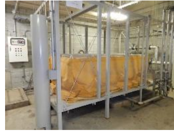
図 13 ガスバッグ(サブステーション) ・容量 10 m 3 ・学内に 4 か所あり、7 m 3 と 10 m 3 が2か所ずつある。 ・2014 年新設
